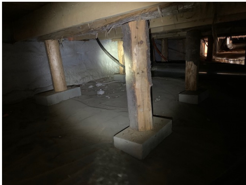
Appuis en bois sous le plancher
