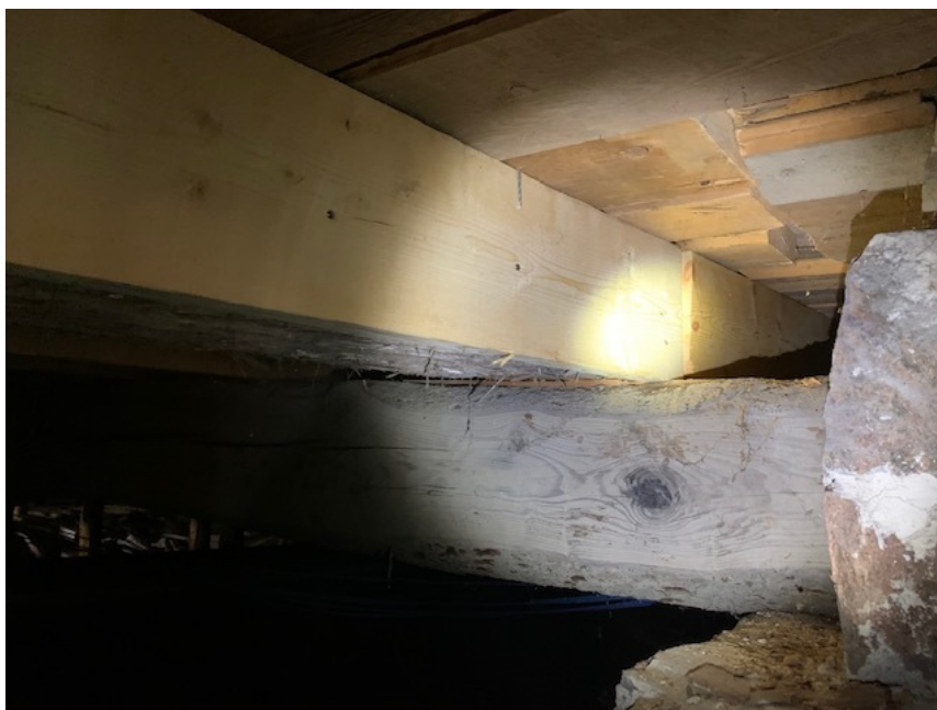
Appui des solives sur la poutre 6x11
